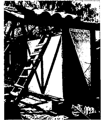
EN OBRA GRUESA....
